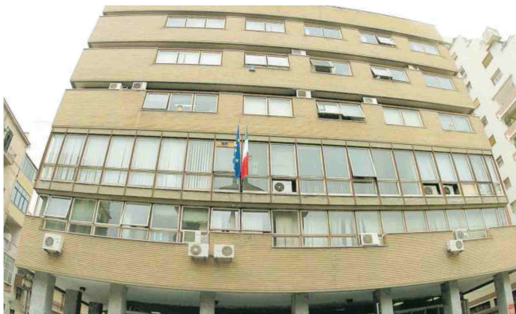
▲ Quartier generale La sede dell'Azienda sanitaria provinciale di Palermo
