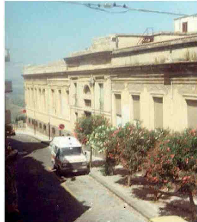
Al via oggi i lavori per la ristrutturazione del piano seminterrato dell'ex ospedale di Mineo
