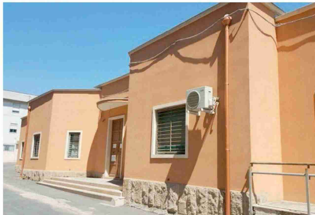
La sede Asp di via Macello
