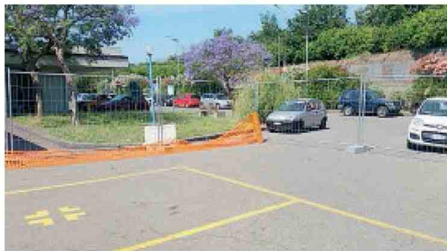
Il cantiere del pronto soccorso
