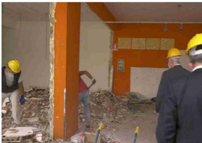
Lavori in corso Nei locali di "Casazza" sui Colli Sarrizzo dell'Irccs
